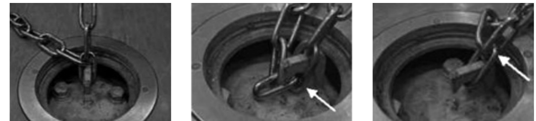
Abb. 3: Richtig eingehängte Kette mit freiem Kettenglied (links), falsch eingehängte Kette mit verklemmtem Kettenglied (Mitte und rechts).
